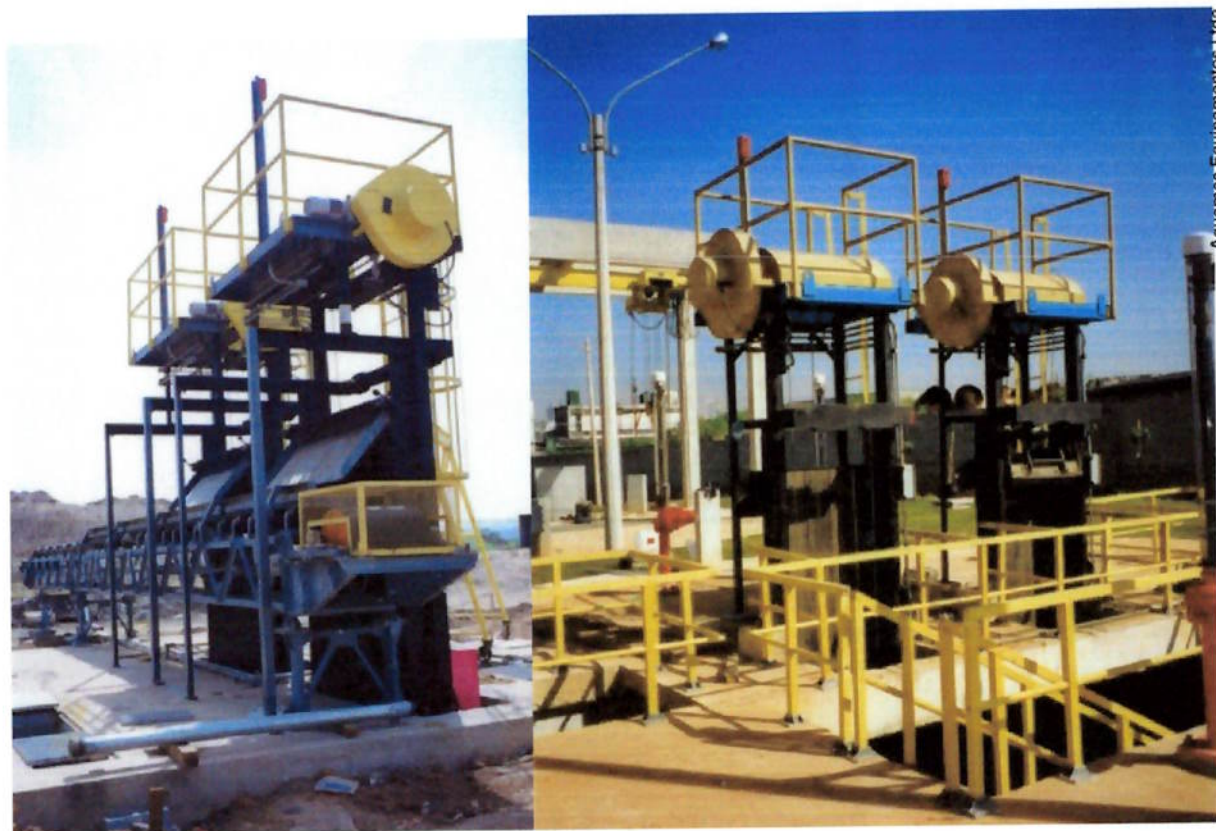
Fig. 3 – Grades de 4 cabos instaladas em ETE.
