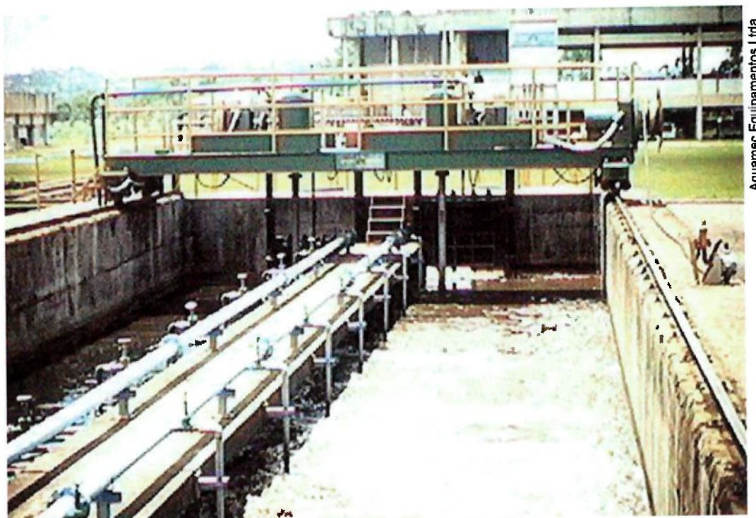
Fig. 5 - Caixa de areia retangular em operação.
