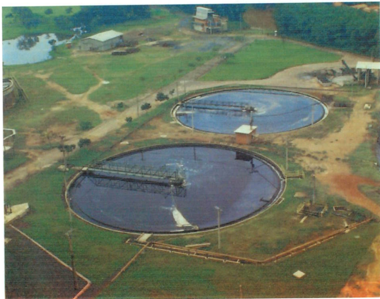
Fig. 15 - Removedores circulares em planta de tratamento.
